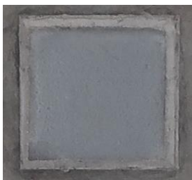
コンクリート橋桁部（100×100 mm）
