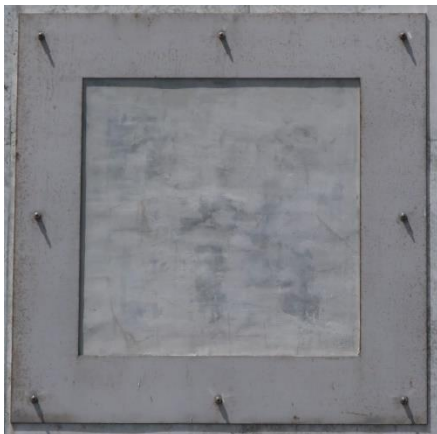
コンクリート橋橋台部（1200×1200 mm）
