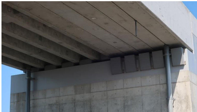
コンクリート橋部
