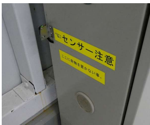
吊りハンガー扉センサー (操作盤横)
