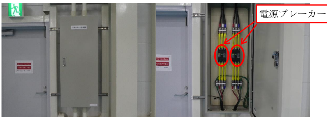
水中ミキサー端子盤（外観）
