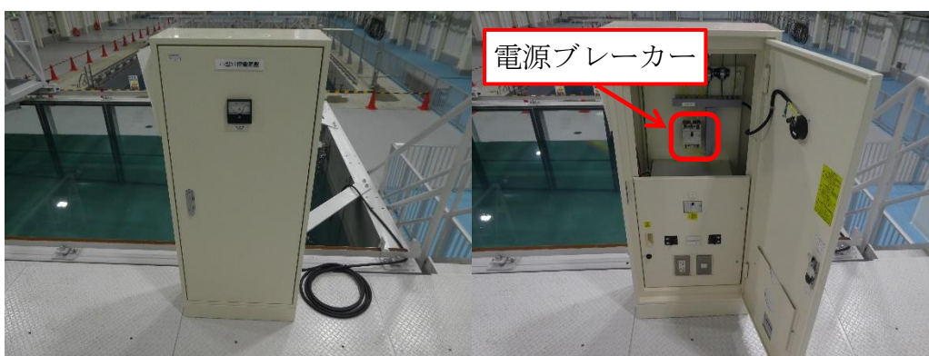
小型水槽電源盤（外観）
