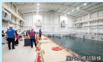
屋内水槽試験棟
